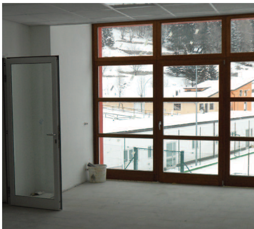
Il locale radio nell'edificio di Protezione Civile
