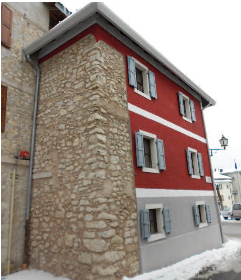
La scarsa qualità dei muri in sasso del municipio non ne ha permesso il recupero a vista
