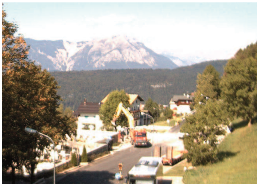
Spostamento e demolizione della cabina elettrica di Via Trento
